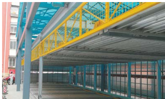
图 4：北京西城区白云路小区改造后的立体停车场
